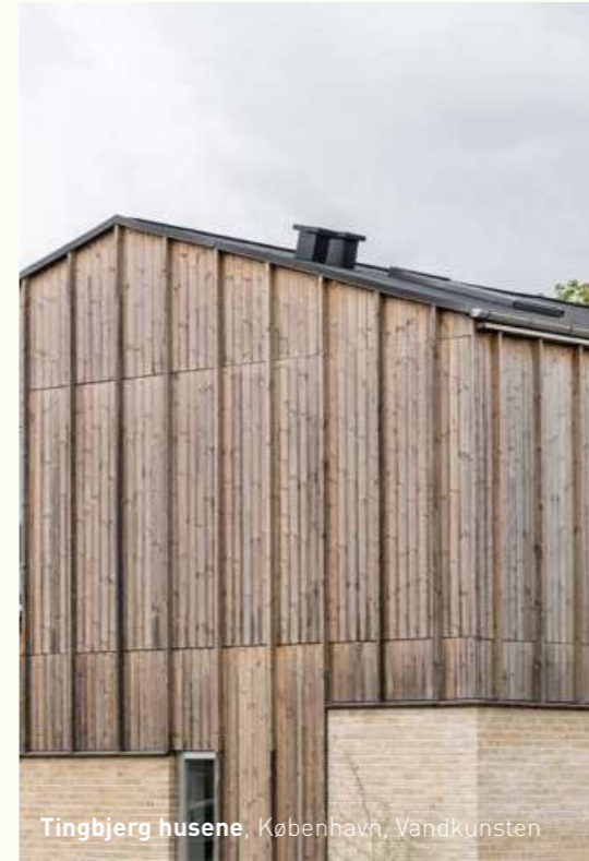
Eksempel. Kontrasten mellem base og midte kan skabes i taktilitet, trods farve-tonemæssig lighed.
