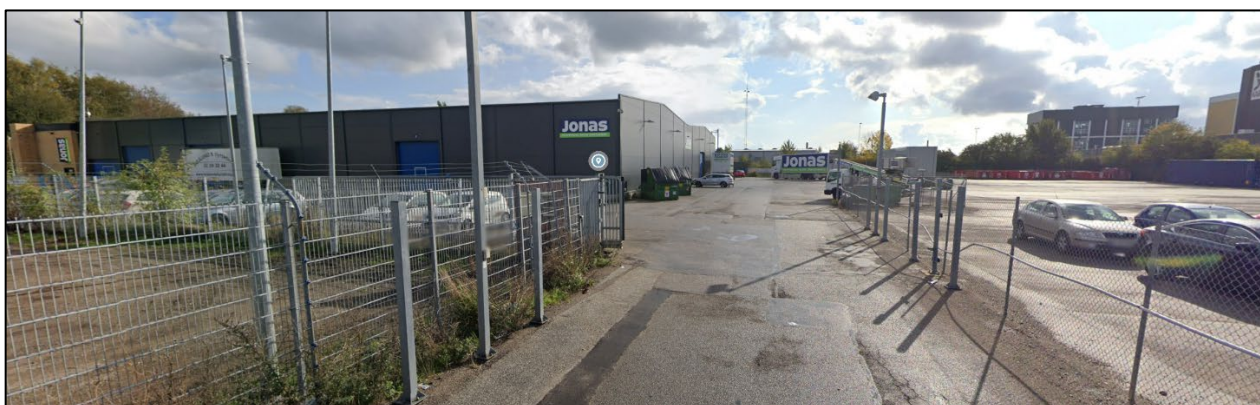
Figur 12.2: Facaden af Fabriksparken 3 set fra den nordlige side. Kaffesiloen ses i den højre side af billedet / Googlemaps /.
