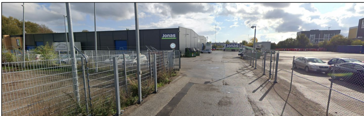
Figur 13.1: Facaden af Fabriksparken 3 set fra den nordlige side. Kaffesiloen ses i den højre side af billedet / Googlemaps /.
