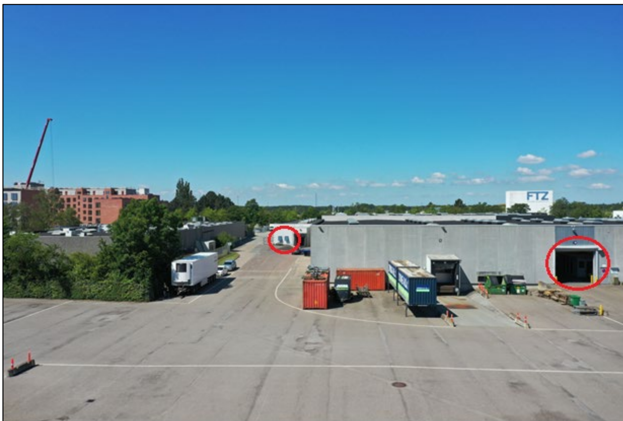
Figur 8.46: Dronebillede i 10 meters højde, svarende til punkt 6 i figur 8.39. Jævnfør lokalplanforslaget planlægges der for op til 6 etager ved denne placering /bilag Indbliksgener/ . Vinduer og port er markeret med røde ringe.
