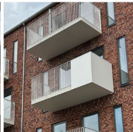
Altan, balusterværn med lukket side og delvist lukket front, fladjern pr. ca. 1-1,5 mtr
