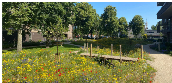
Forsinkelsesbassin med små overgange for fodgængere
