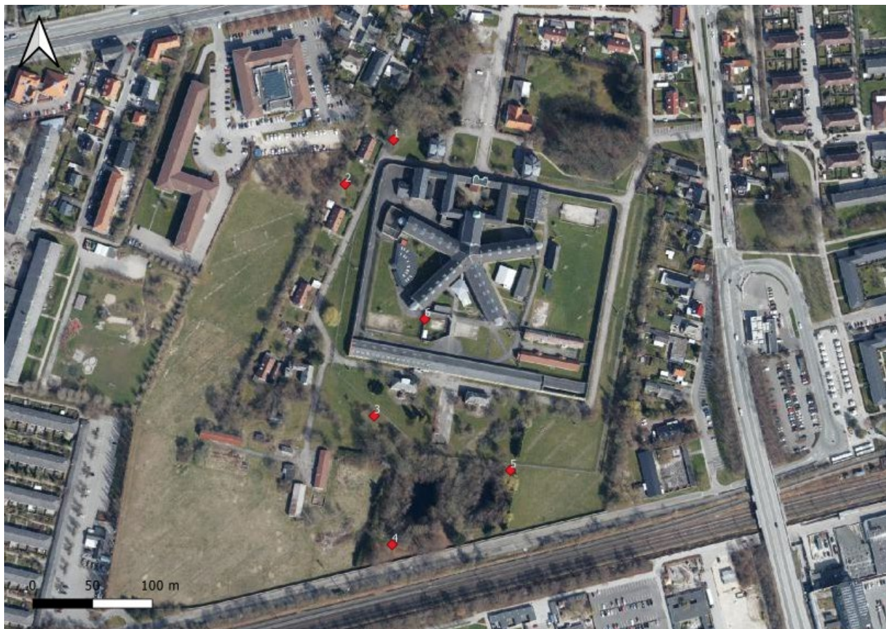
Figur 2 Flagermusdetektorerne markeret med røde romber placeret spredt strategisk i forhold til potentielle flagermustræer der ønskes fældet samt for at lytte inden for fængselsmuren efter ynglekolonier i bygningerne.
