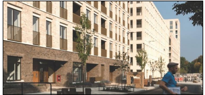
Figur 15: Eksempel på en base der markerer sig tydeligt i det samlede facadeudtryk. Den overvejende del af bebyggelsen kan opføres i op til 6 etager, hvor 6. etage skal fremstå med markering af toppen i form af tilbagetrukket tagetager og materialeskifte.
