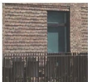
Relief i murværk i stueetagen danner skyggevrkninger og små variationer i fløjbjælde. Kilde: Amaryllis Hus, Mangor & Nagel
