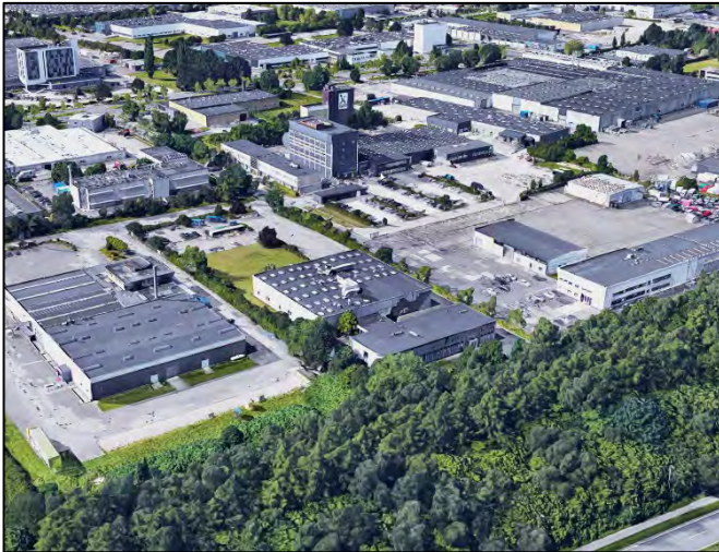
Figur 0.3: Ejendommen i dag set fra sydøst med kaffetårnet i baggrunden og Nordre Ringvej i forgrunden.
