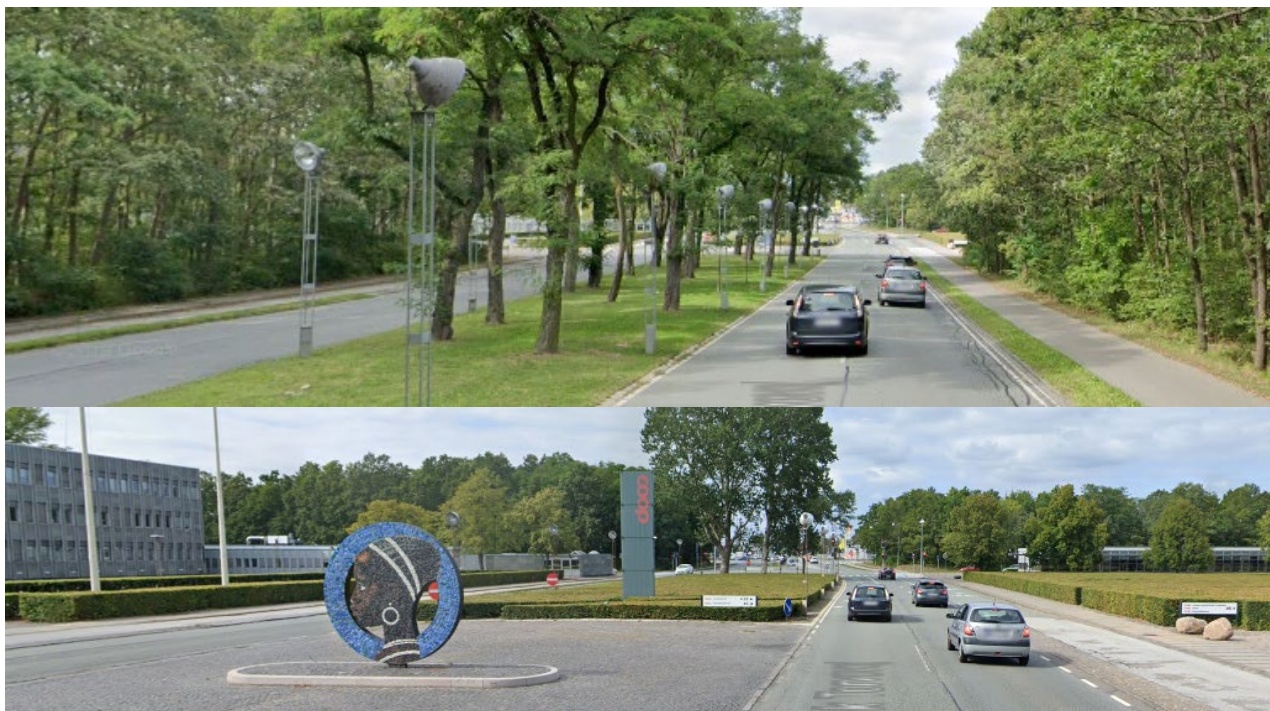
Figur 2. Vallensbæk Torvevej har ved Coop en bred tværprofil med to spor i hver retning, midterrabat, cykelstier og fortov. Set fra syd mod nord. GoogleMaps 2019.
