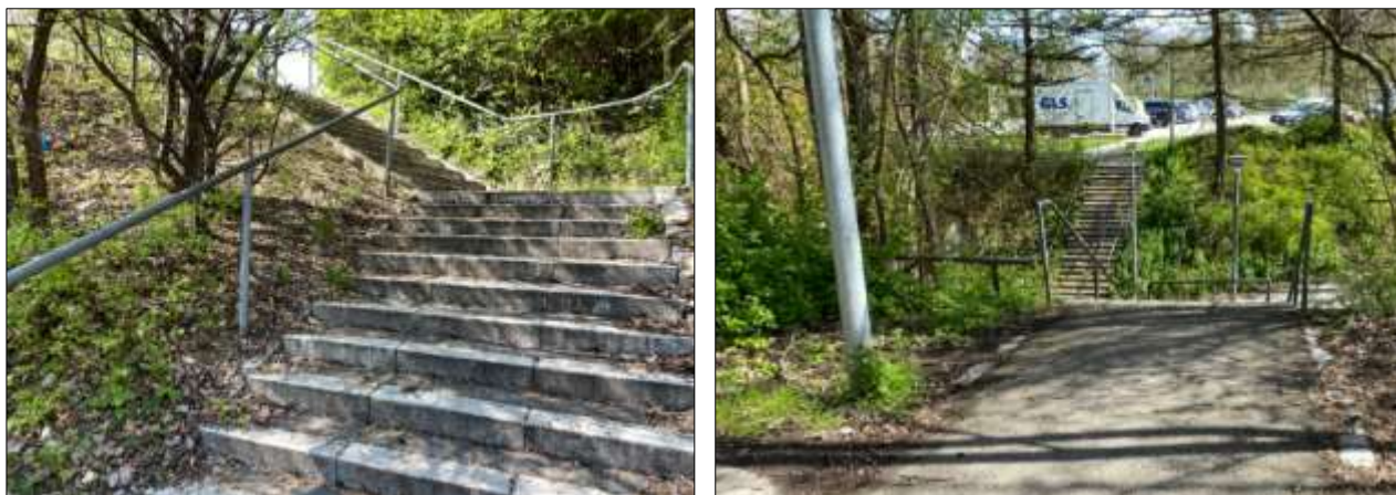
Figur 3: Til venstre ses trappen op til det nordlige busstoppested og til højre en af trapperne op til det sydlige busstoppested. Som det ses, er trapperne meget lange
