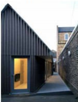
4. Byggeri med havneudtryk
