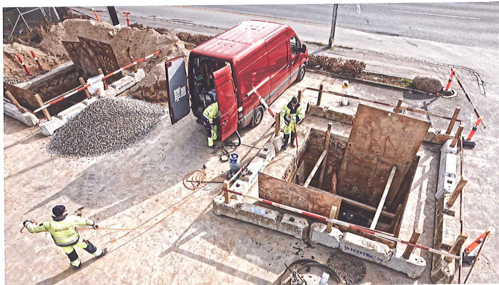
Opgravninger er jævnligt nødvendige i vedligeholdelsen af VEKS' rørsystem
