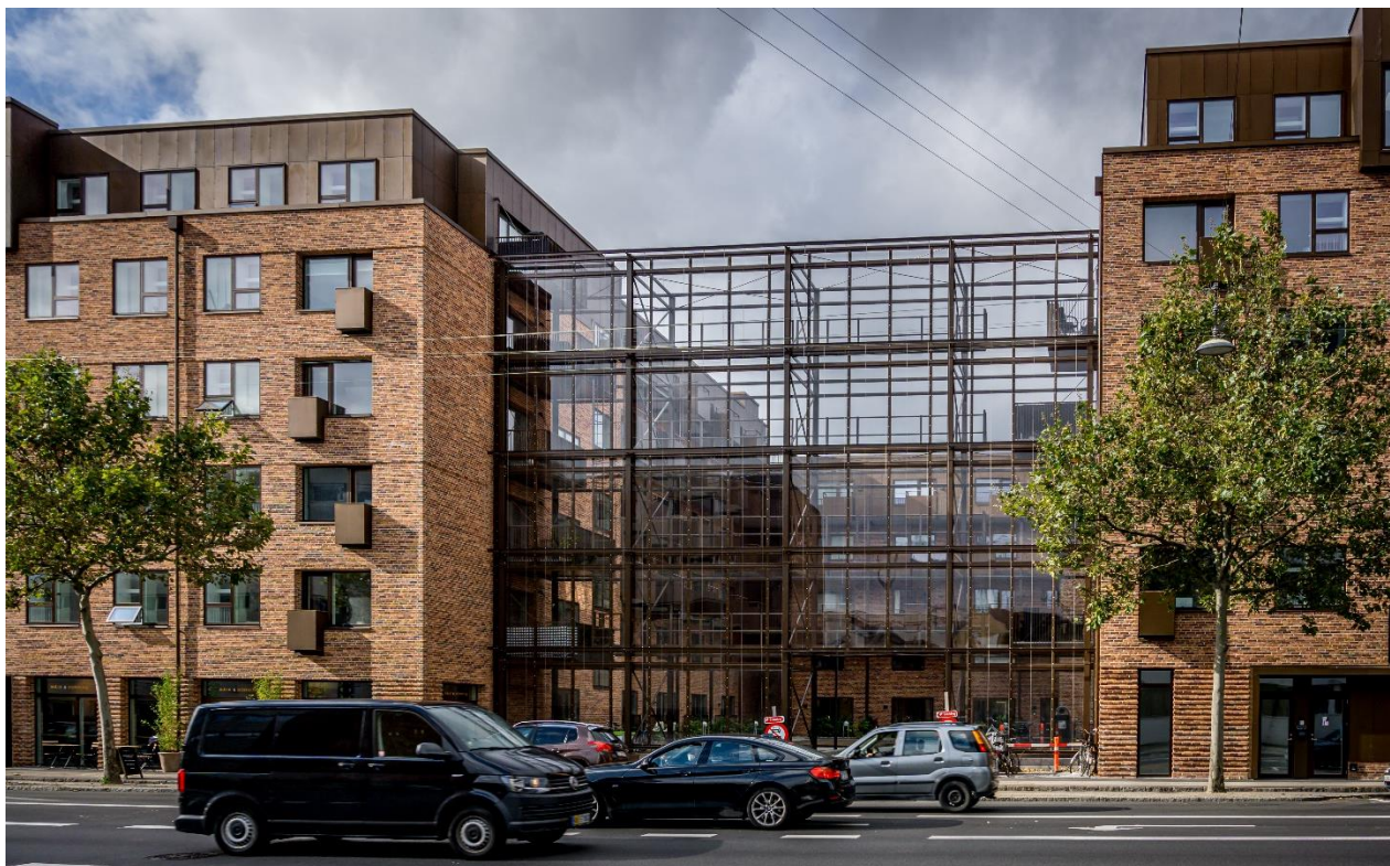
Figur 33. I denne nye bebyggelse, har man anvendt en støjskærm i åbningen mellem bygningerne for at opnå et lavt støjniveau i bebyggelsens gårdmiljø. I facaden mod vejen er der anvendt særligt støjdæpende vinduesløsninger (Gl. Køge Landevej, København).
