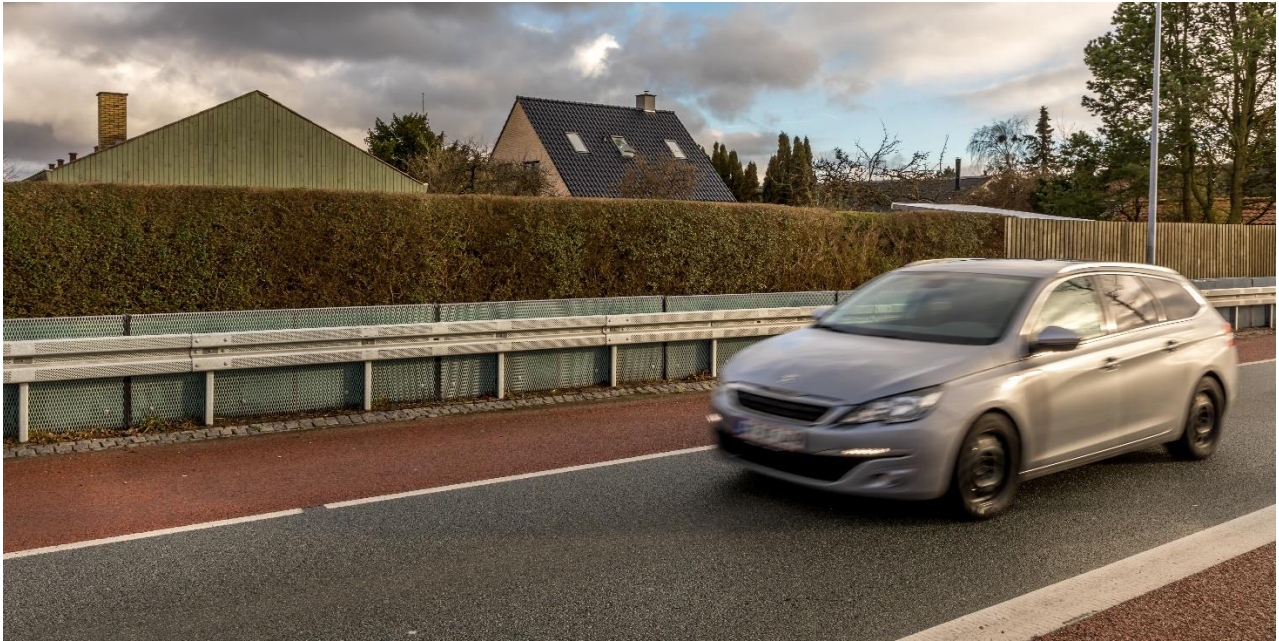
Figur 29. Autoværn, der er udformet som en lav støjskærm. Selvom skærmen er lav, kan der være en støjdæmpende virkning, fordi den står meget tæt på støjkilden (Vejlegårdsvej, Vallensbæk Kommune).
