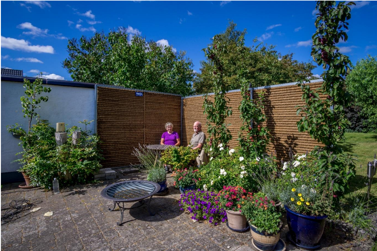
Figur 38. Et støjhegn kan skabe en støjafskærmet krog eller terrasse. Den støjdæmpende virkning kan opleves i et mindre område lige op af hegnet (fra en forsøgspstilling i en have i Glostrup).
