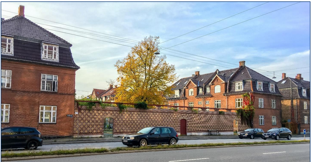
Figur 41. Her har en grundejerforening bygget en støjskærm i åbningen mellem to husrækker. Resultatet er et støjbeskyttet område bag skærmen (Lyngbyvej, København)
