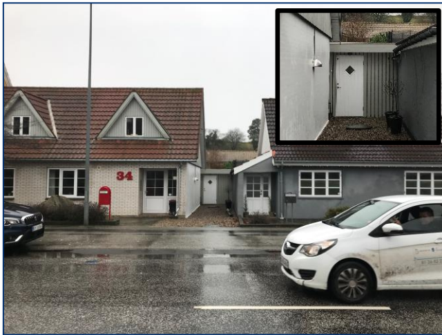
Figur 40. Boligerne skærmer for støjen, men der kommer støj ind gennem smøgen mellem de to huse. Ved at sætte et hegn (her også med en dør) i smøgen, er støjen i baghaven dæmpet mærkbart.
