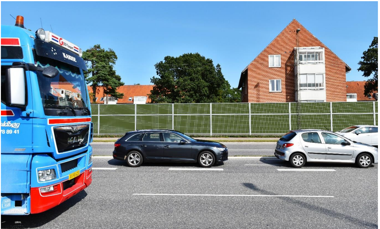
Figur 30: Eksempel på støjskærm ved et etageboligområde. Støjskærmen dæmper støjen på de udendørs opholdsarealer bag skærmen og for boligerne i stueetagen, men ikke for boligerne på 1. og 2. sal.
