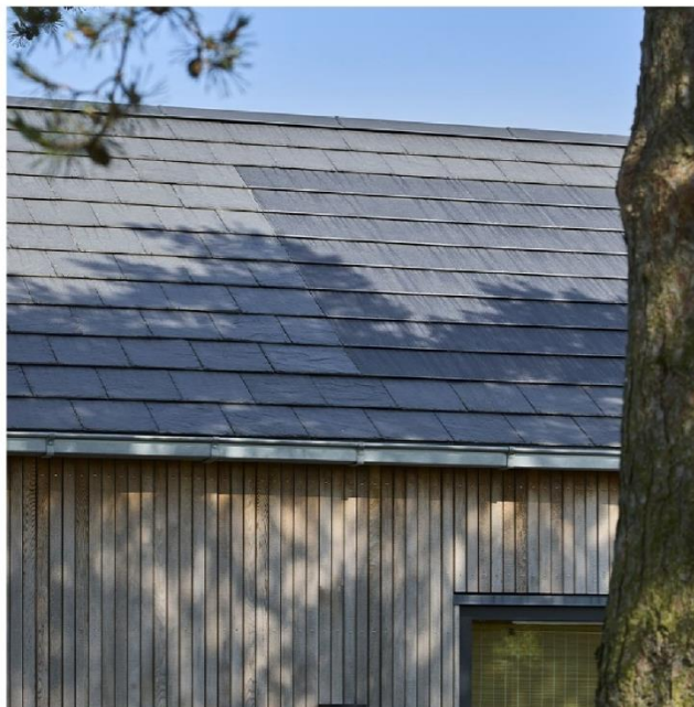
Eksempel på facade med lodret træbeklædning og eksempel på tag beklædt med skifer
