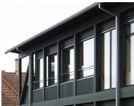
Eksempel på facade med malet træ og eksempel på tag med udhæng
