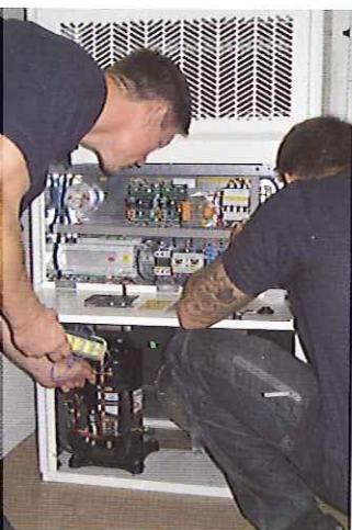
Køleteknikere fra leverandøren Aircold lægger sidste hånd på monteringen af det nye frikølingsanlæg.
