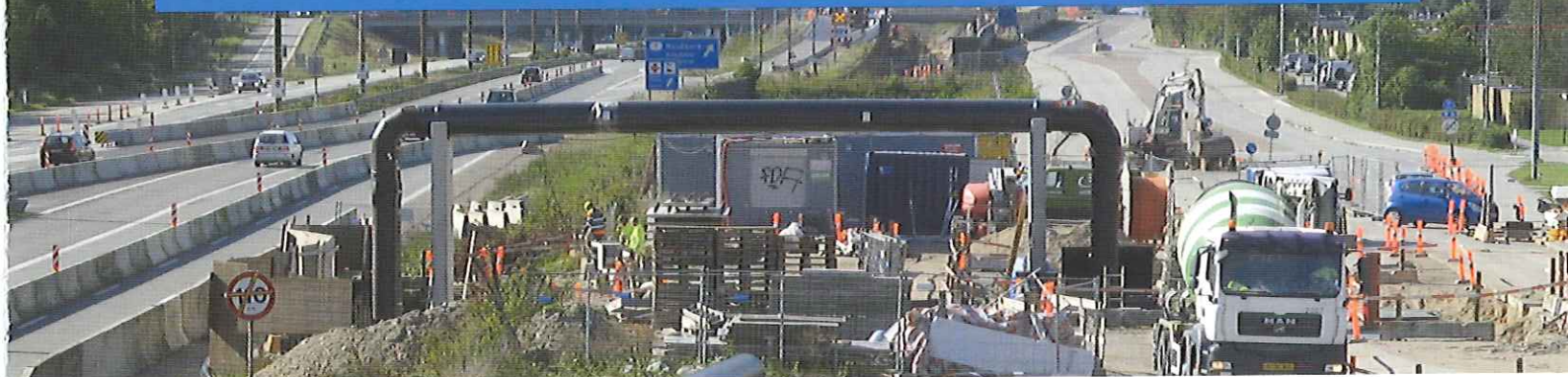
Umiddelbart til højre for den nye rørbro, gemmer den nye station sig 8 meter under vejen
