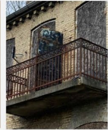
Eksisterende værn på altan og bloktaandsgesims
