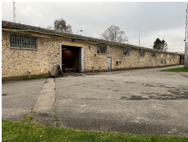
Figur 10: Værkstedsbygningens nordlige facade
