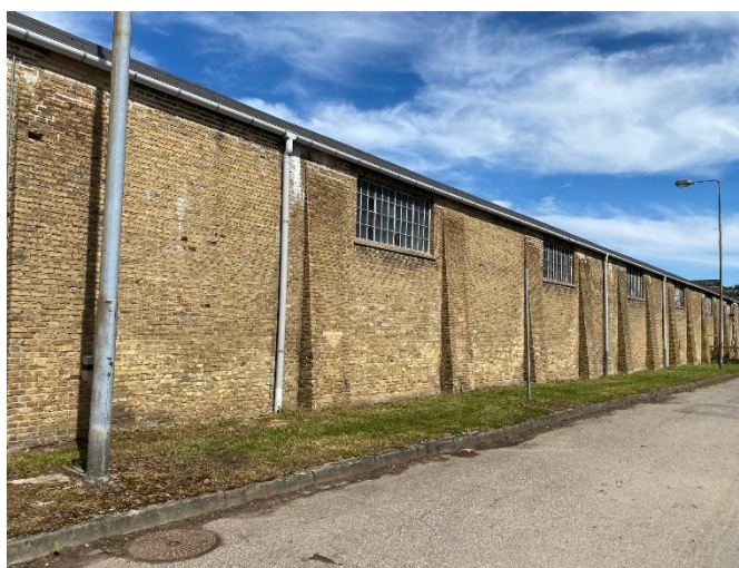
Figur 9: Værkstedsbygningens klimaskærm mod syd er den oprindelige fængselsmur, som udgør en helt særlig fortælling og kulturhistorisk spor i området. Særligt stræbepillerne er karakteristiske for muren.
