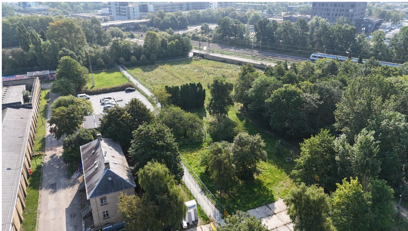
Figur 3 Lokalplanområdet set mod Albertslund Station og Alberts Vænge. I baggrunden ses broen over jernbanen og Albertslund Centrum. Forrest ses den eksisterende fængselsmur og bagvedliggende værkstedsbygning. Overfor muren ses Østre Bagbolig.
