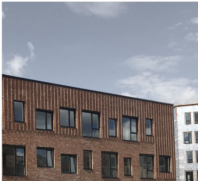
Vandret markeret top med murværksdetalje, Grønttorvet, Valby
