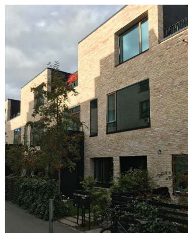
Markering af vindue som dybtliggende og gående ramme i træ, Islands Brygge, (Vandkunsten)
