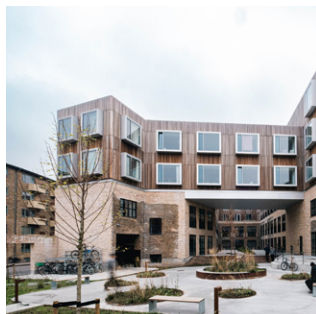
Eksempel på tagmotiv uden tilbagetrækning, men hvor der laves et skift i materiale fra resterende facade.
