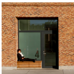
Eksempel på detaljering af base ved brug af tilbagetrækning ved indgangsparti, hvor der også er indtænkt et siddeelement.
