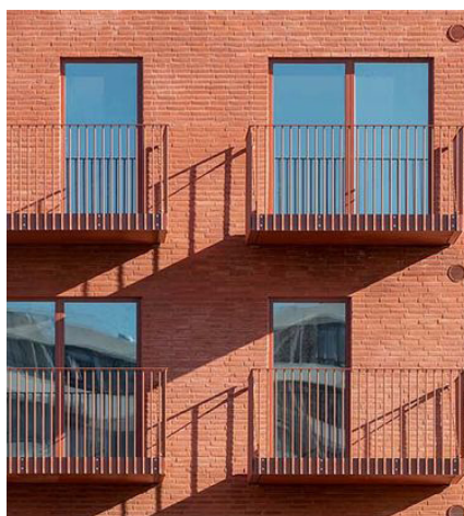
Eksempel på påmonterede altaner. Reference fra Æbeløen, Aarhus.
