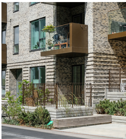
Eksempel på delvist indeliggende altan. Altanerne ligger placeret i en fordybet niche over hinanden, hvor siderne er lukkede. Reference fra Fælledkanten, Ørestad syd.
