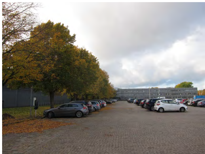
På den østlige del af den store plads danner tørvarelageret (den store fladebygning 9 i L-form) væg omkring pladsen, og lagerets massive væg uden åbninger blødes op af en træække, der fortsætter på tværs af midterrabatten og afsluttes foran hovedindgangen på den vestlige del af pladsen.
