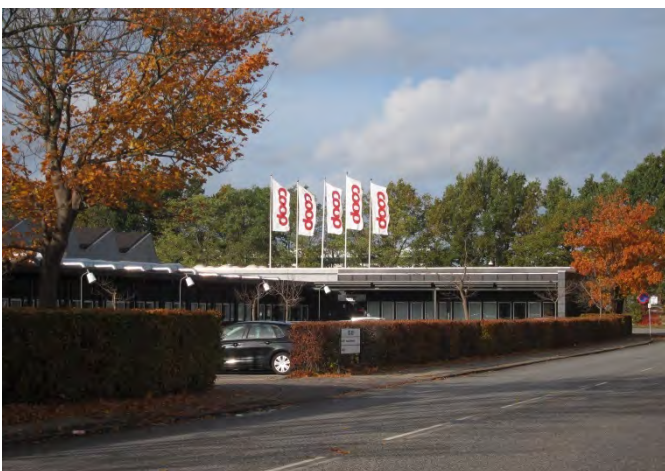
Den nordlige kontorlænge bliver til en fritliggende bygning i den østligste del. Beplantningsbæltet langs Roskildevej omkranser anlægget med sin grønne træække bag bygningen.
