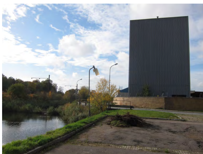
I det sydøstlige hjørne ved kaffetårnet er området tydeligt afgrænset af vandhul og beplantning mod banen og definerer en tydelig grænse mod syd.
