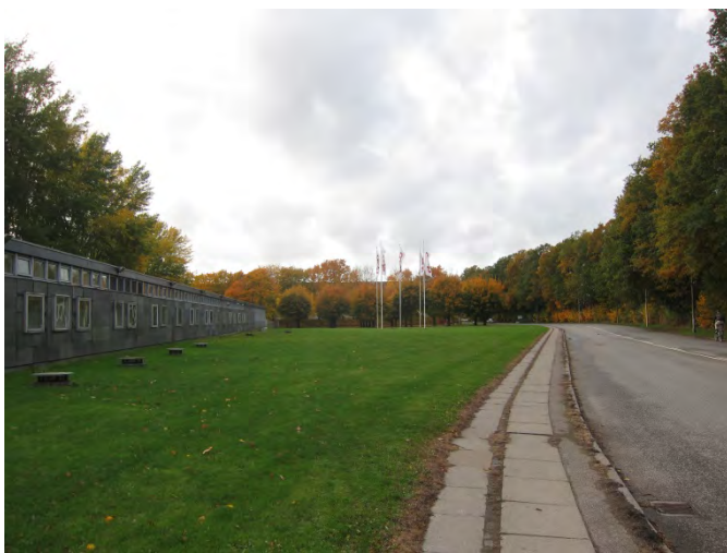
I anlæggets nordvestlige del spiller Læhegnets bugtede karakter op til anlæggets og bygningernes retvinklede former. Bag flagene for enden af parkeringspladsen står en trægruppe plantet i et kvadratisk net, der i sin stramhed står flot sammen med grupper af mere løsslupne blafrende flag; et lignende motiv ses i anlæggets nordøstlige del.
