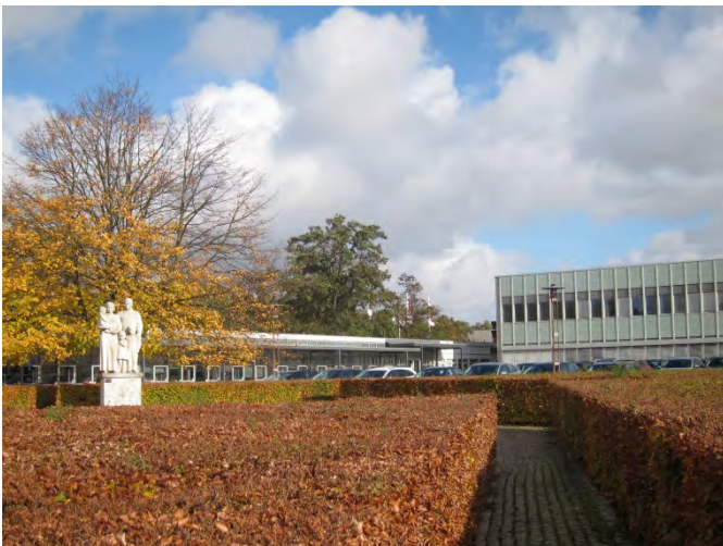
Forpladsen foran kontorbygningen i delområde 2. Der er et tydeligt hierarki mellem den lave bygning mod nord og kontorbygningen, der understreges som den vigtigste i kraft af sin højde og placering midt på pladsen. Til venstre ses skulpturen Familien Danmark, der står på den sekskantede logoformede plads med udstrålende ganglinjer skåret ud i den tætte hækbeplantning.
