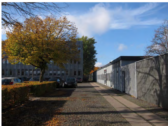
Den lange, lave bygning leder blikket og bevægelsen fra forpladsen og videre forbi hovedbygningens gavl til de åbne grønne arealer på bagsiden af hovedbygningen. Den lave bygning underordner sig hierarkiet og lade hovedbygningen træde frem som den vigtigste bygning.
