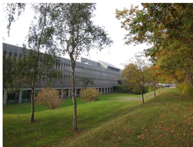
Øst for hovedbygningens sydlige længe er terrænet faldet yderligere bearbejdet bl.a. i forbindelse med vejens stigning mod broen over jernbanen (til højre). Bygningen er afskærmet fra vejen med et tæt beplantningsbælte. Der er etableret en diskret brandvej, der følger terrænfaldet.
