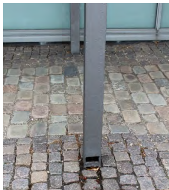
En detalje: Baldakinernes søjler tjener også som nedløbsrør.
