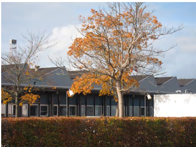
Når man kommer lidt på afstand, f.eks. fra vejen Læhegnet, ses fabriksafsnittets takkede profil med shedtagets række af ovenlys tydeligt over den foranliggende lave kontorlænge, der har fladt tag som de øvrige bygninger i hele anlægget.
