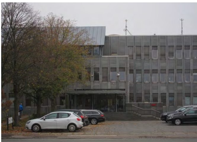
Indgangspartiet på hovedbygningen, som det ser ud i dag. Den oprindelige baldakin er fjernet, der er etableret trapper op til indgangsdøren, og på taget er opført et ny påbygning med skrå tag.
