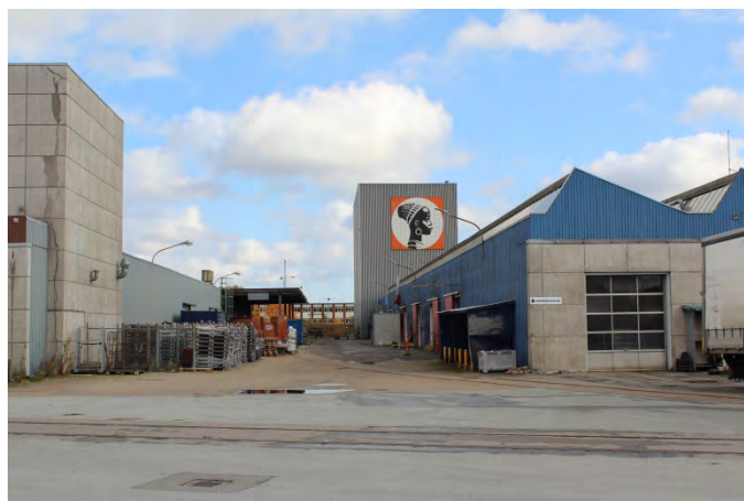
Kig mod øst i det fortættede område mellem fabriksafsnittet til venstre og centralværkstedet til højre og kaffetårnet i baggrunden. Stedet byder på mange oplevelser i skalaspringet, Cirkelpigen, de store skydeporte, jernbanespor, overdækninger og gadelamper – detaljer der både historisk og fysisk er med til at give et helt særligt miljø.
