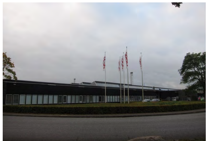
Den nordlige kontorlænges nordfacade overholder den modulære inddeling, men fremstår mere simpel i formgivning og materialer.
