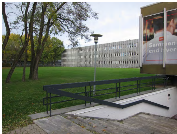
En bred trappe med elegante værn fører til indgangspartiet i kantinens nederste etage. Det flade, åbne græsklædte areal nord for kantinen kranses af de forskellige bygninger, beplantningsbælter og trærækker, og stringensen brydes af spredte mere organisk placerede trægrupper.
