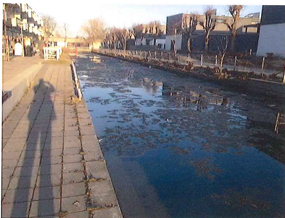
Prøvestykket hvor gangarealet er tættere på vandet
