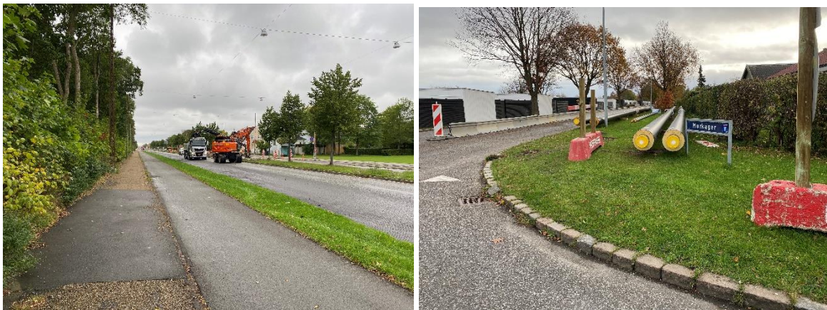
fig. Roskildevej lukket 3-4 dage for trafik i begge retninger i forbindelse med asfalt og fjernvarme arbejde. Trafikken ensrettet på Egelundsvej.
