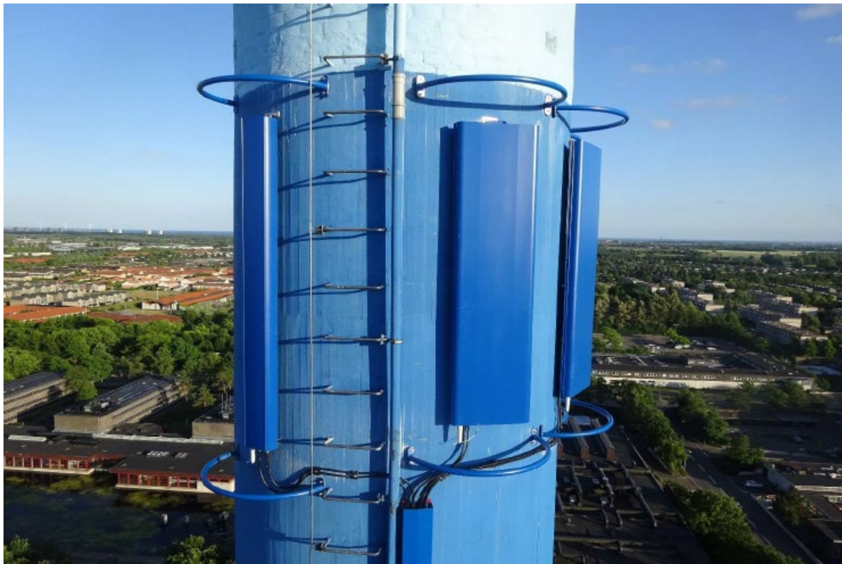
Antenner på skorstenen
