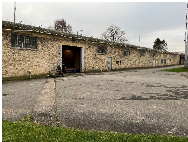
Figur 10: Værkstedsbygningens nordlige facade
