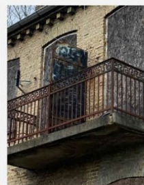
Eksisterende værn på altan og bloktandsgesims
