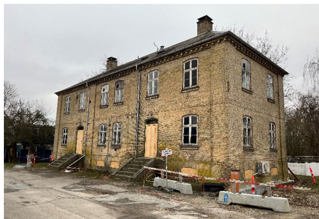
Figur 7: Østre Bagbolig set fra nord med bloktandsgesims under taget og murstik over og under vinduerne
