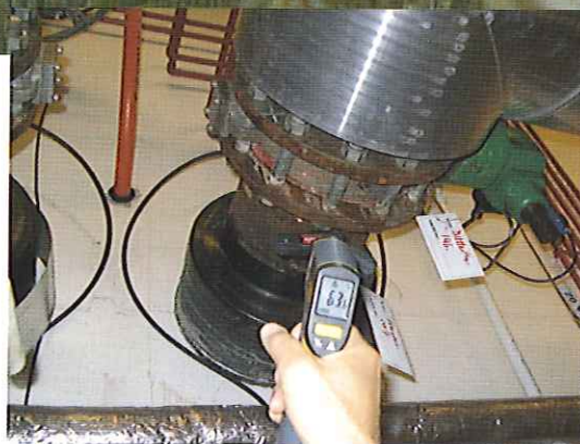
Overfladetemperaturen var 63 grader på et af de 197 spots, som snart beklædes med isoleringsmætter.
