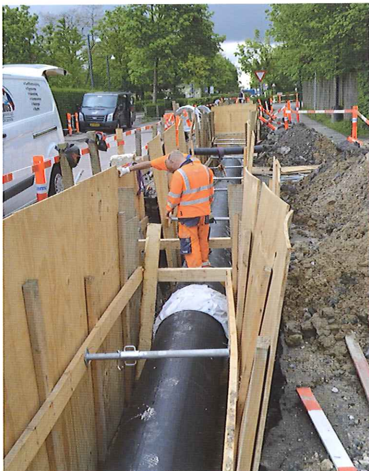
Anlægsarbejdet i Valhøj (i den sydlige del af kommunen) skrider planmæssigt frem og afsluttes inden årets udgang.
