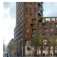
• Bygningssknæk åbning mod stationsplads
