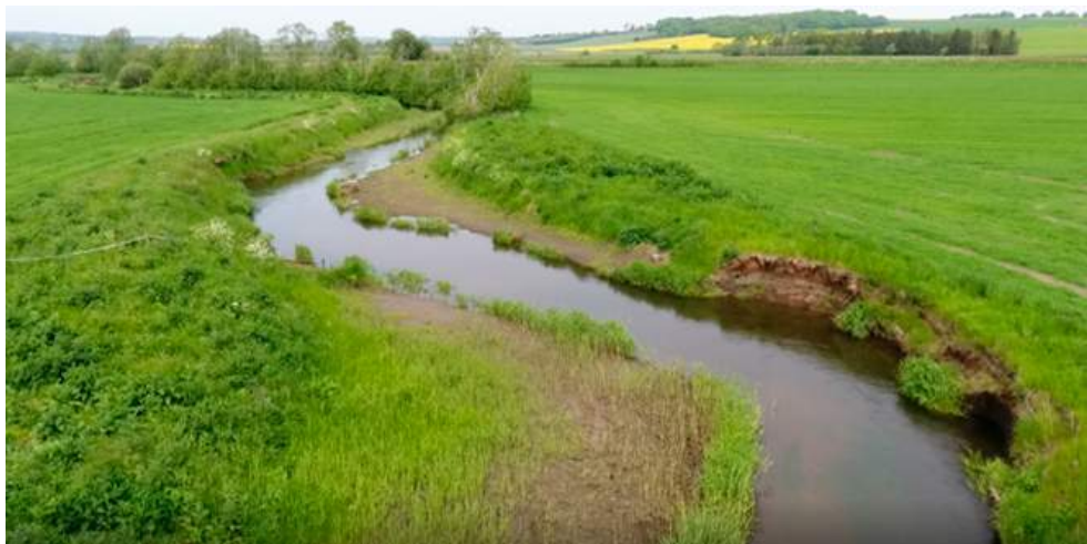
Figur 4-3 Eksempel på dobbeltprofil fra Lilleåen ved Hadsten med anlagte lave partier langs vandløbet (figur fra Seges Innovation)
