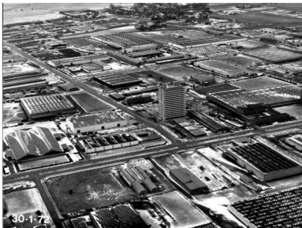
Hersted Industripark set fra Øst i januar 1972. Foto. Lokalhistorisk Samling, Albertslund.
