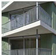
4. Altanværn af lodrette balastre i stål
