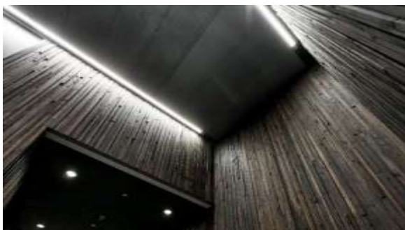
Eksempel på vægpaneler i Copenhagen Towers. Panelerne består af vinduesrammer, rammetræ fra fyldningsdøre og brugte gulvbrædder. Træet bearbejdes og brandimprægneres og gennemgår evt. tørring. Herefter monteres stavene på krydsfinérplader der herefter er klar til montering. Koncept og produktion af Lendager Up og Genbyg
