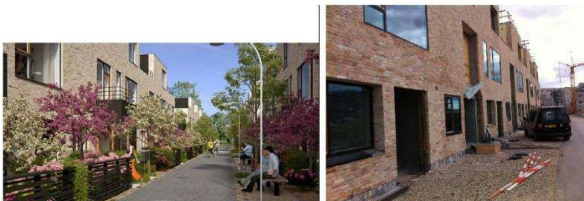
Eksempel på genbrug af mursten i byggeriet Havnevigen på Islands Brygge (Vandkunsten og NCC). Her er 750.000 sten genbrugt fra hhv. Værløse kasserne og Hundsbøl Frøavl
