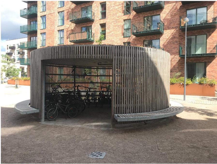
Eksempel på overdækket cykelparkering i listebeklædt skur med dobbeltfunktion som ophold eller leg
