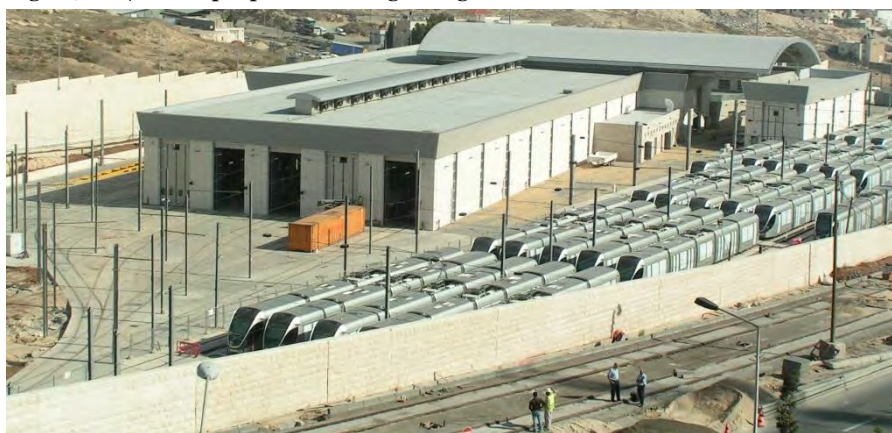
Figur 3-28 | Eksempel på kontrol- og vedligeholdelsescenter til letbanen (Jerusalem).
