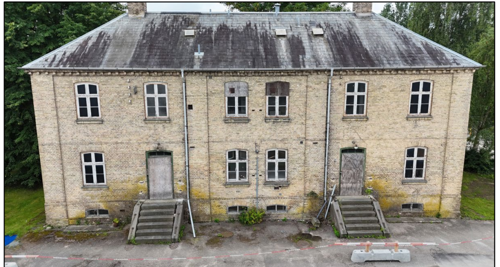
Figur 5-11 Østre Bagbolig set fra nord. Foto Cobe.
