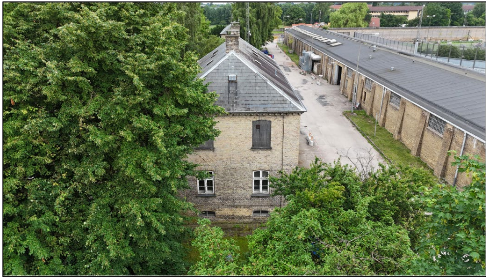
Figur 5-16 Til venstre ses Østre Bagbolig og bevaringsværdige træerne på boligens sydside. Til venstre ses værkstedsbygningen og Fængselsvej, der adskiller Østre Bagbolig og værkstedsbygningen. Bag værkstedsbygningen anes den tidligere fængselsgård med trådhegn, lysmaster m.m. Foto Cobe.
