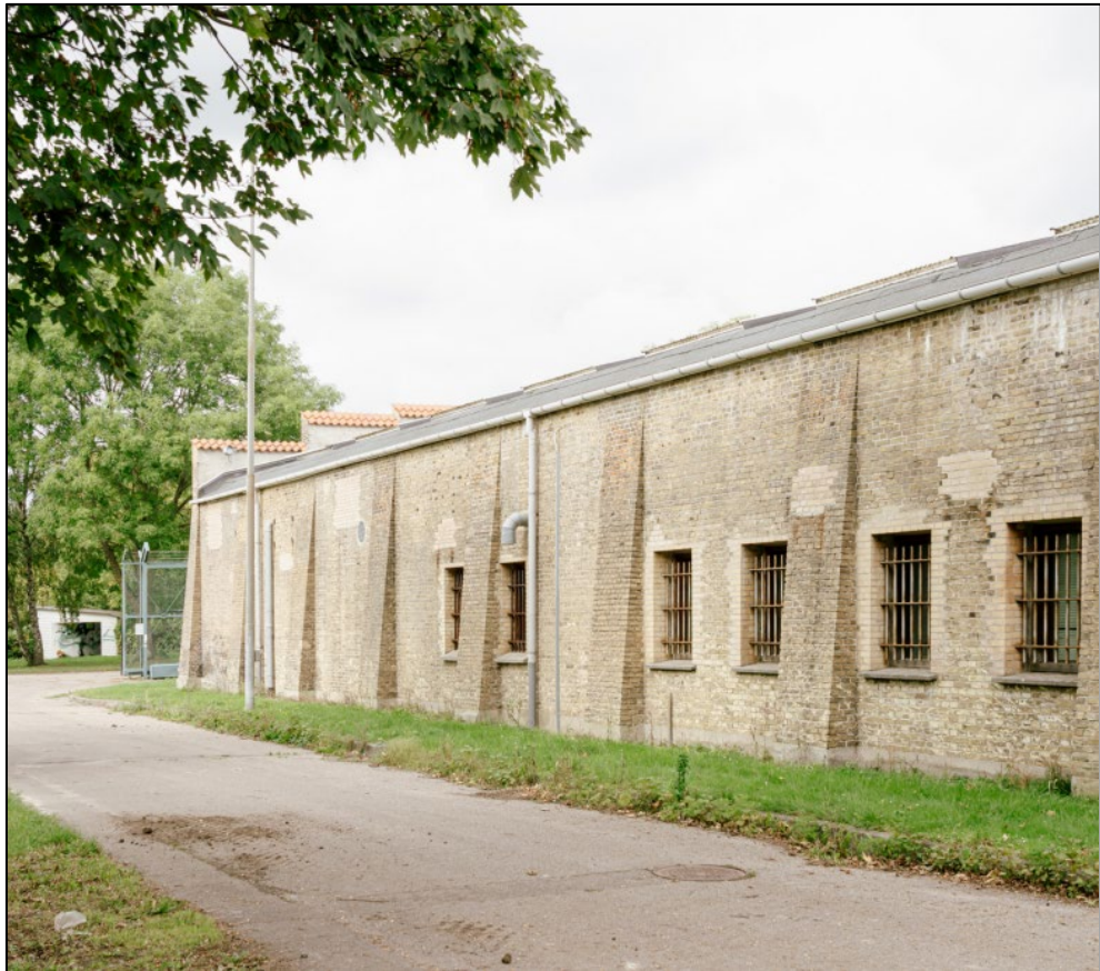
Figur 5-12 Værkstedsbygningens sydfacade udgøres af den oprindelige fængselsmur med de karakteristiske støttepiller. Foto Cobe.
