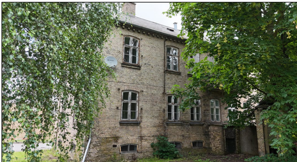
Figur 5-10 Østre Bagbolig set fra syd. Foto Cobe.
