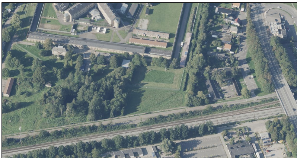
Figur 5-8 Skråfoto fra september 2023. Øverst ses det tidligere fængsel og værkstedbygningerne. Syd for Bagbolig Vest og Bagbolig Øst ses den eksisterende beplantning og beplantningen i skel mod Alberts Vænge ses til højre. Foto COWI.
