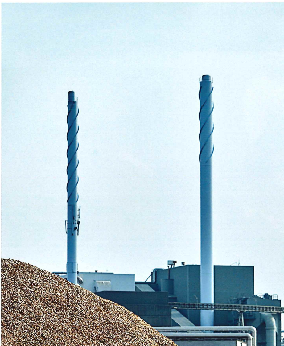
Køge Kraftvarmeværk Foto: Peuckert Photography
