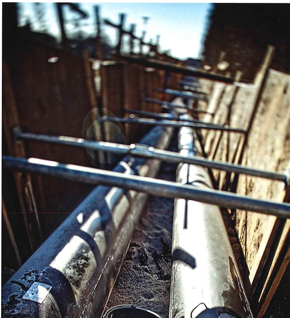
VEKS' system omfatter i alt cirka 134 km dobbeltrør. Dertil kommer systemet i Køge - her ved et tidligere anlægsarbejde. Foto: Peuckert Photography
