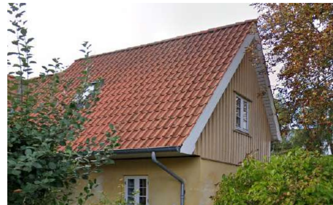
Herstedvester Landsby: Rødt stejlt tegltag, guldpuddet facade, gulmalet lodret bræddegavl.
