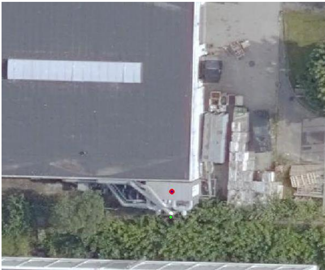
Figur 9.5 Luftfoto af Q-railing ventilationsanlæg ved bygnings sydøstlige hjørne. Ventilationsanlæg medtaget i beregning er markeret med blå prik. Grøn prik angiver skelpunkt mod nabo, hvor nuværende støjramme er 60 dB(A) hele døgnet.
