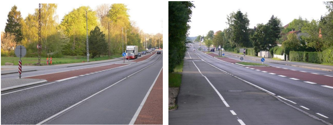
Figur 4.9 Eksempler på markering af midterarealer, hvor svingning er tilladt. Løsningerne anvendes i situationer, hvor det ønskes at dæmpe hastigheden ved at indsnævre køresporene og skabe større afstand mellem de modkørende, og hvor det ønskes at midterarealet benyttes til svingning for at øge fremkommeligheden for den ligeudkørende trafik. De kantstensafrænsede heller kan desuden benyttes som en sikker krydsningsmulighed for gående eller cyklister. Løsningen på billedet til venstre viser et midterareal afgrænset af kantstensafrænsede heller for at sikre, at midterarealet kun benyttes ved svingning. Løsningen til højre viser et midterareal med punkteret kantlinje på hele strækningen pga. mange ind- og udkørsler. Der er etableret kantstensafrænsede midterheller med jævne mellemrum for at sikre, at midterarealet kun bliver benyttet til svingning.
