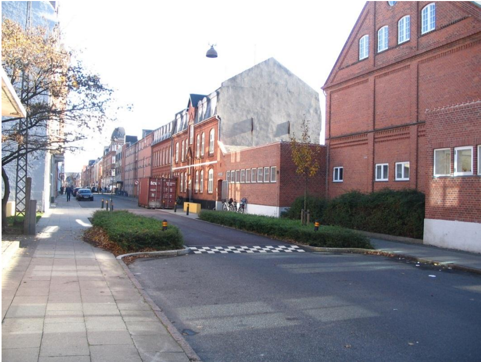
Figur 3.12 Indsnævring til 1 spor med hævet flade
