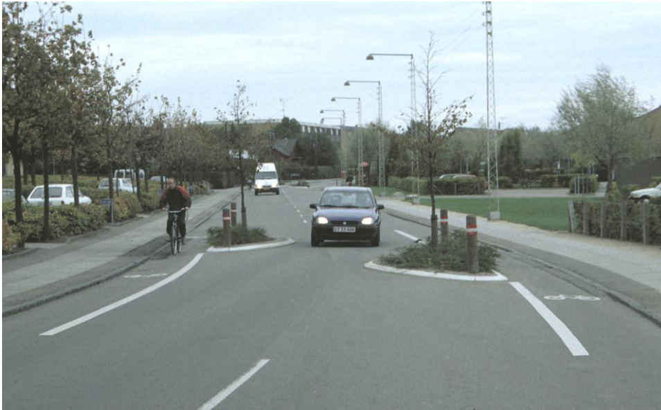
Figur 3.13 Forsætning med indsnævring
