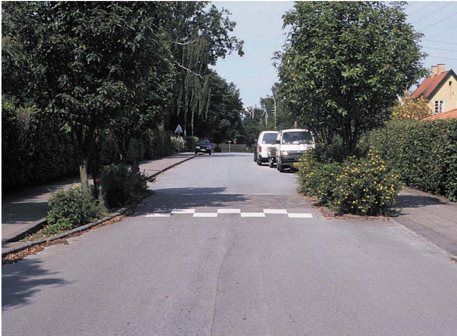
Figur 4.44 Skakbrætarmærkning (S32) på rampe
