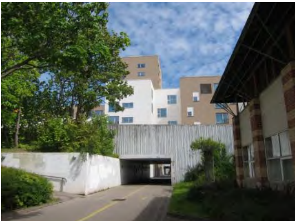
Den nyere bebyggelse omkring Sundhedshuset ses mod øst bag tunnelen, der fører under Albertslundvej. Stien forbinder Albertslund Centrum med Albertslund Syd øst-vest. En trappe/rampe til venstre forbinder de forskellige niveauer.
