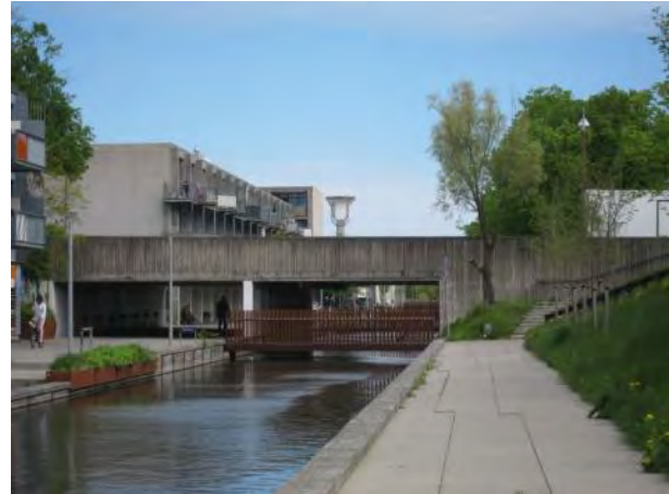
Fodgængertunnel og kanal er ført under Albertslundvej mod syd ved Albertslund Syds østlige grænse.
