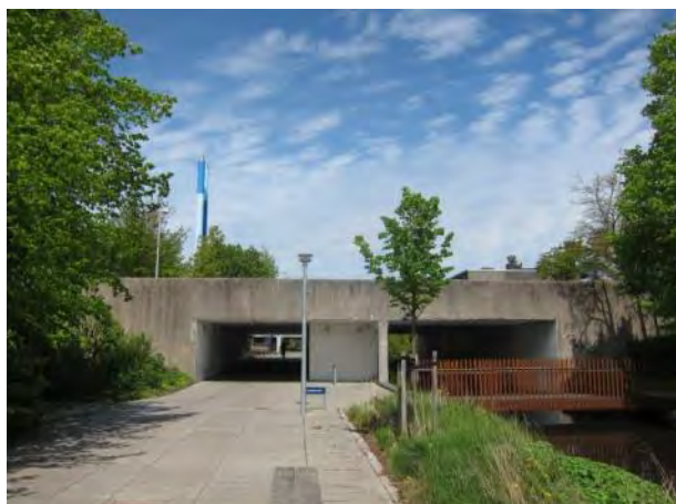
Skorstenene set fra syd over tunnelerne under Nordmarks Allé.
