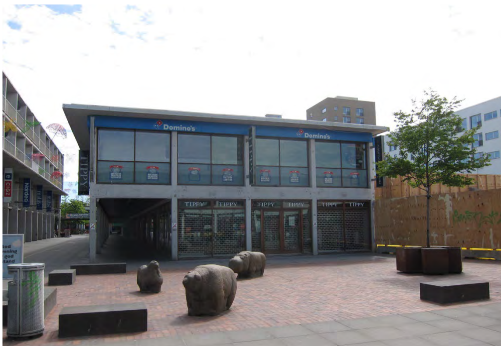
Længen vest for butiksgaden set fra Stationstorvet mod syd. Modulopbygningen er tydelig. Kolonnaden inviterer indenfor.
