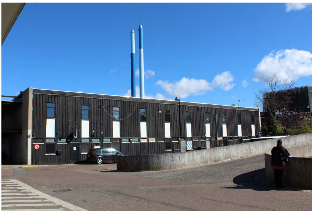
Sydlangens sydfacade, der vender ud mod en parkeringsplads. Facaden står ret intakt i sit facadeskema, der både har lodrette linjer i kraft af vinduesfelterne og vandrette linjer i kraft af de lave, horisontale vinduesbånd.
