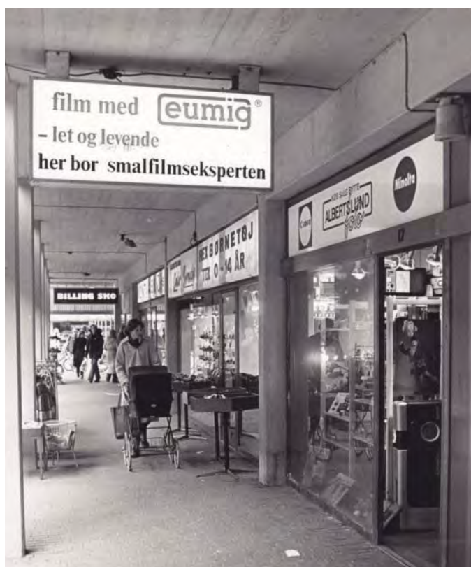
Historisk foto fra 1982, der viser den ene arkade i butiksgaden. Betonen med aftryk af forskallingsbrædder ses tydeligt i loftet. På dette tidspunkt er skiltningen vandret over butiksvinduerne og på tværs i arkaden. Arkivfoto B2585, Lokalhistorisk Samling Albertslund. Fotograf Ole Kristensen.
