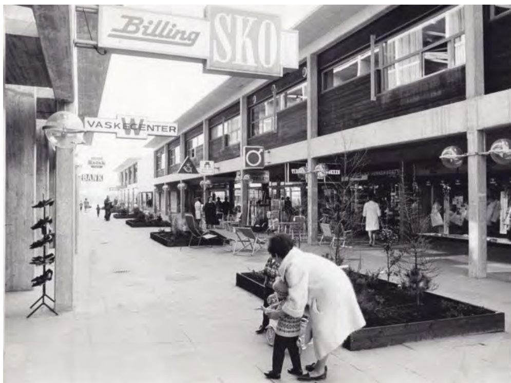
Historisk foto fra 1967. Butiksgaden set mod syd og Bytorvet. Læg mærke til den rustikke bræddebeklædning og de vandrette vinduespartier på første sal. Arkivfoto B2559, Lokalhistorisk Samling Albertslund. Fotograf ukendt.
