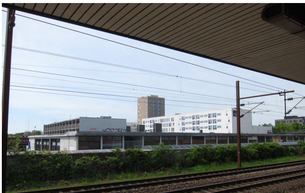
Nord- og østfacaderne ses fra perronen på S-togsstationen.
