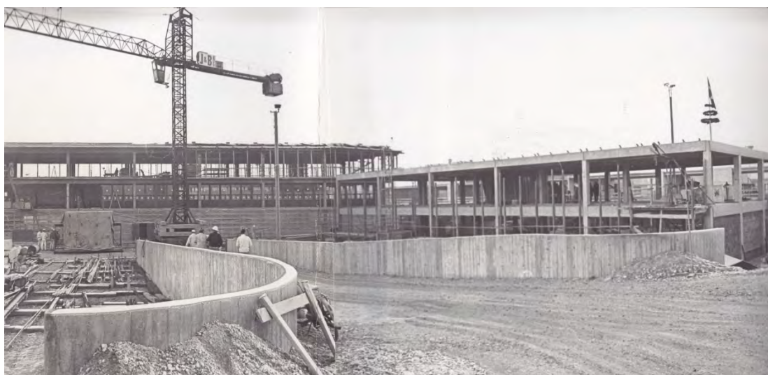
Historisk foto fra 1968, der viser rejsegilde på den sydlige længe ved Bygangen. Selv om gavlene og smalle felter i facaderne er af teglsten, viser billedet, at konstruktionen er af beton. Arkivfoto B2551, Lokalthistorisk Samling Albertslund. Fotograf Allan Rene Hygom.
