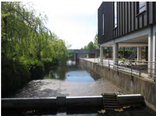
Fra broen mellem biblioteket og rådhuset kan man kigge mod syd og følge Kanalens forløb under Nordmarks Allé. På broens/tunnelens side er der kunstnerisk udsmykning.
