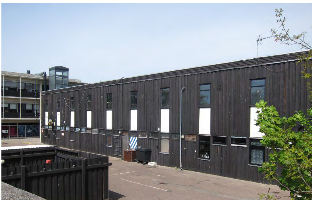
Sydfacaden på sydlangen set mod vest med Arbejderbos kontorhus i baggrunden. Bræddebeklædning har helt fra starten været et karakteristisk træk i bebyggelsen, og selv om beklædningen her fremstår slidt, bidrager den til en varieret materialeanvendelse med levende overflader.
