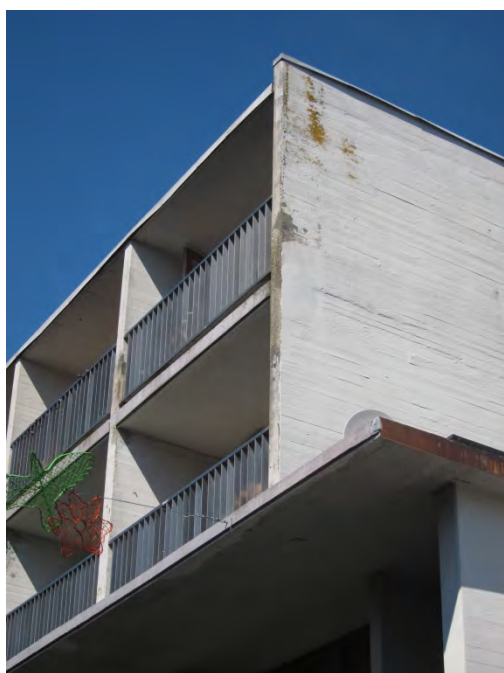
I den fireetages bygning langs butiksgaden ses aftrykkene af bræddeforskallingen i de in situ støbte gavle tydeligt.
