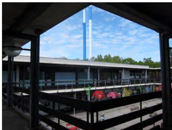
Set mod nordøst fra gangbroen, der forbinder Bygangens to bygninger, er skorstenen med til at lette orienteringen.
