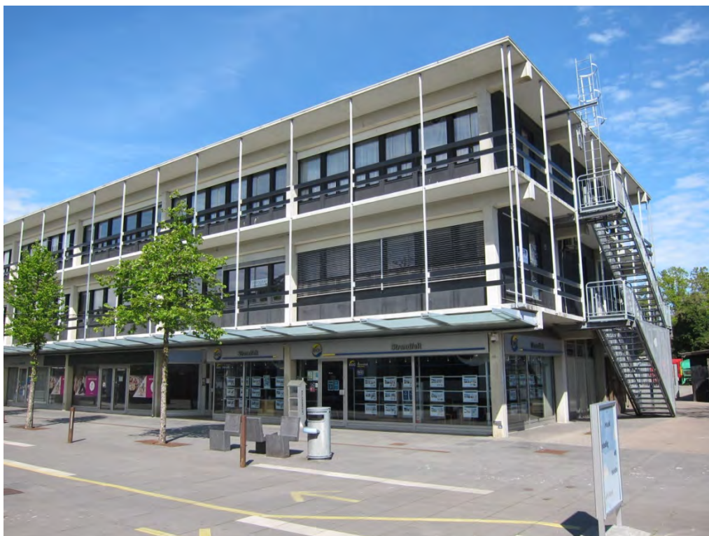
Vest- og sydfacaden med den noget voldsomme brandtrappe i gavlen.
