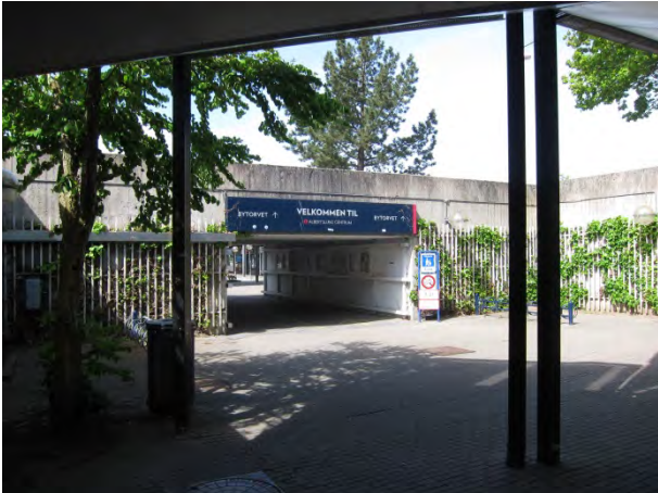
Tunnelen under Vognporten set fra pladsen foran Musikteatret mod vest til gennemgangen til Albertslund Centrum.
