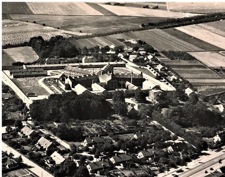
Et luftfoto fra 1943, hvor det ses hvordan funktionærboligerne ligger fint omkring statsfængslet. Samt den direkte kobling til hele fængslet via en allé fra Roskildevej, hvor kirken og indgangspartiet var et tydeligt pejlemærke og måske gav associationer til et slot/herregård.
