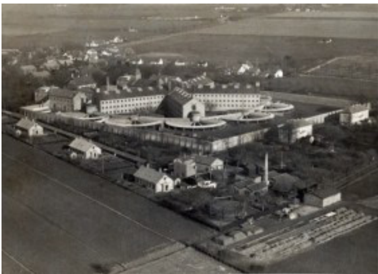
T.v. ses de nye funktionærboliger - gasmesterens bolig med gastankene samt gartnerierne i den sydlige del.
