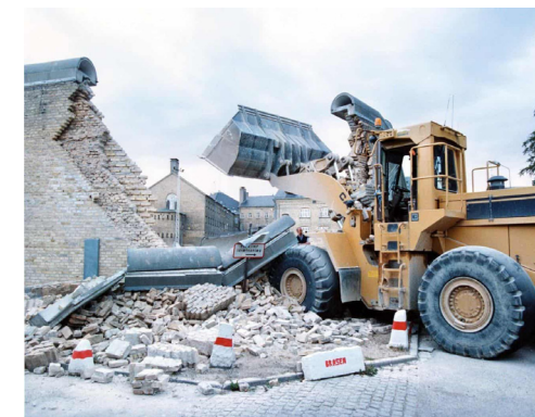
Gummigeden efter påkørslen af muren.
