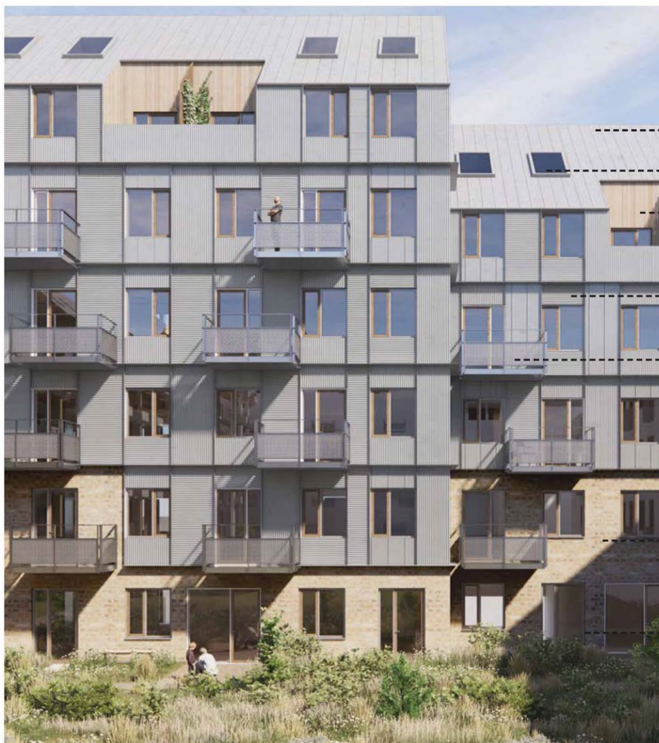
Eksempel på facadeudsnit af gårdfacade med grå stålplader
