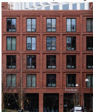
Eksempel på gridstruktur ved brug fremspring i tegl. Foto: AART.
