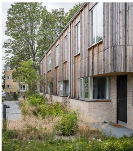
Eksempel på indgangsniche med hjørnevindue og tegl som bagvæg
