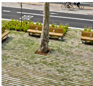
Eksempel på 'grøn' belægning på brandudstignings-areal
