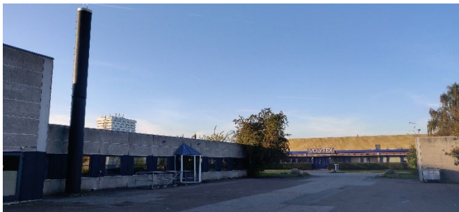
Figur 6: Foto taget inde fra grunden i det nordøstlige hjørne, hvor der kigges ud mod Smedeland.
