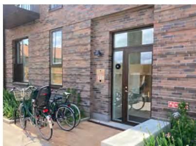
Eksempel på veldefineret indgang med cykelparkering i smal kantzone. Også et eksempel på detaljering af murværket med fremtrukne murskifter. © 2022 Kuben Management
