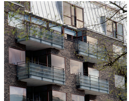
Tilbagetrukket tagetage med tagterrace (Charlottehaven)
