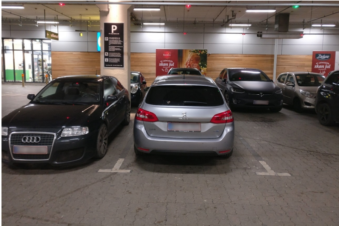
Figur 3.4 Parkeringsanlæg med single space detektering med rød/grøn lampe i loftet over hver bås.
