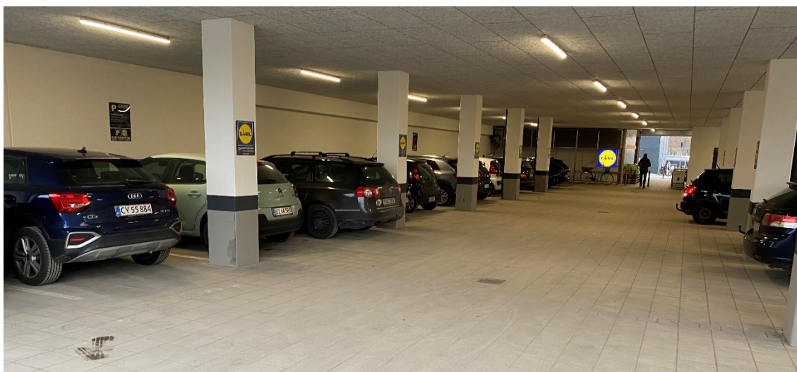
Figur 4.4 Eksempel på parkeringsanlæg, hvor placering af søjler vanskeliggør manøvrering ind/ud af parkeringsbåsen.
