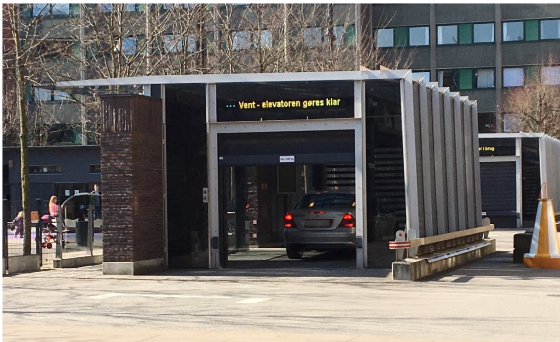
Figur 3.8 Eksempel på et fuldautomatisk parkeringsanlæg.
