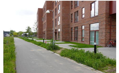
Det første lille stykke af Vandstien er anlagt nord for Murervangen.
