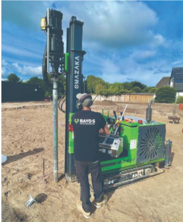
Eks på maskine som der etableres skruepæle med
