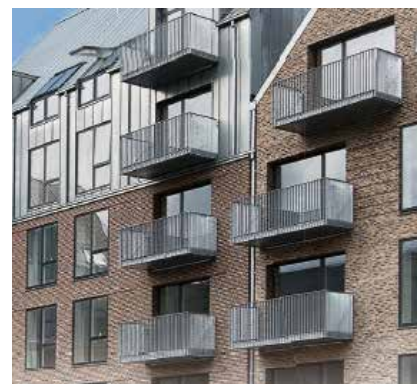
Altanvæm med balustre i galvaniseret stål
