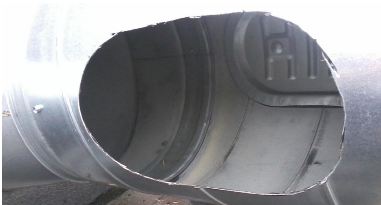
Figur 4. Nyinstalleret kanal på udsugning fra restaurant køkken
