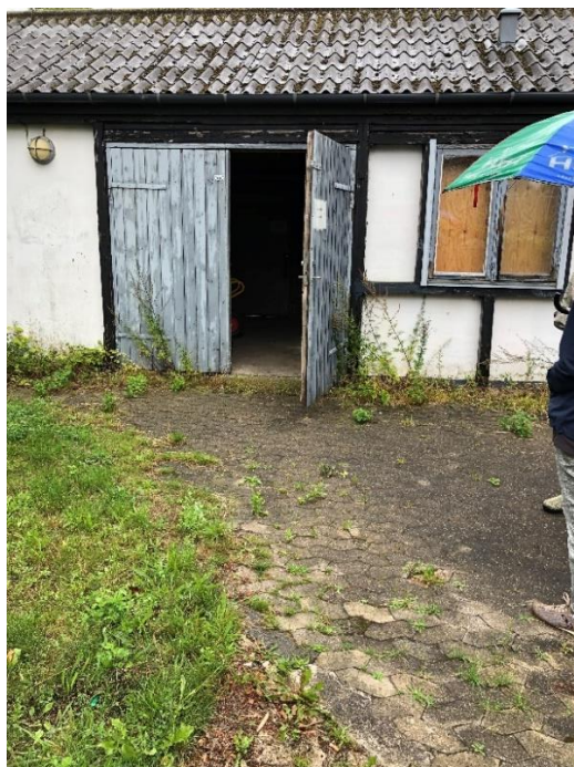
Eksempel på adresse med udfordrende adgangsforhold. Her skal renovatøren gennem flere døre som er låst med forskellige nøglesystemer. Adressen er udfordret af at området er under totalreivering.
