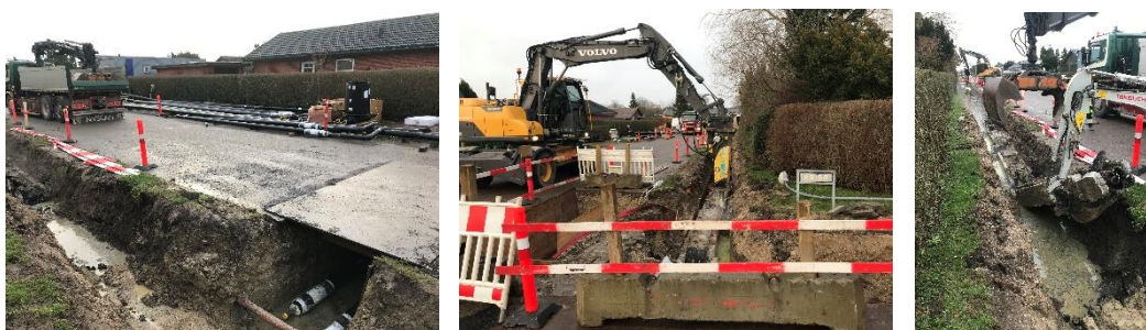
fig. Gammel betonkanal med fjernvarmerør bankes over i 3 m. stykker og køres bort for at give plads til nye miljøvenlige fjernvarmerør
