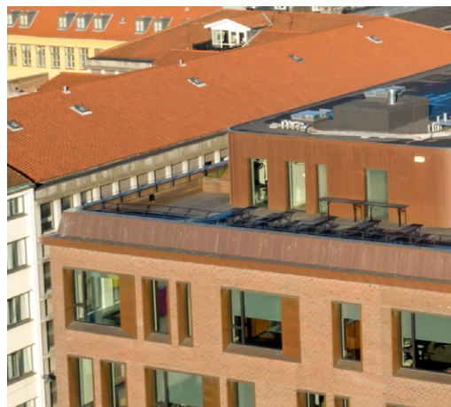
Eksempel på tagterrasse værn udført lukket med tagmotiv i metalplade. Indvendigt mod selve terrassen er overfladen udført i træ.
