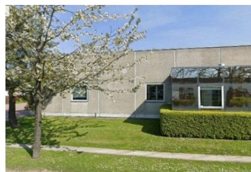
Figur 10: Foto, som viser områdekarakteristisk bebyggelse for Hersted Industripark. Bygninger opført i hvide betonelementer og med fladt tag.
