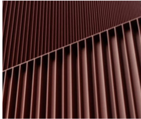
Eksempel på plademateriale udført i aluminium med lodret reliefvirkning. Reliefvirkningen er her lavet i 2 forskellige bredder og dybder, der er adskilt med vandret bånd der adskiller de to reliefbredder.
