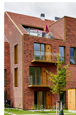
Eksempel på altanværn udført i glas med punktvisse afbrydelse med lodrette balustre hvorpå glasset er monteret.
