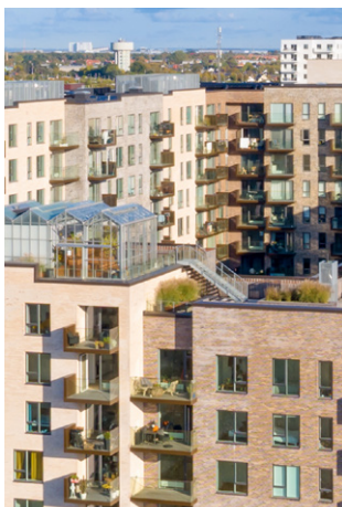
Eksempel på tagterrasse værn udført i kombination af glas og lukket muret værn som er en fortsættelse af facaden.
