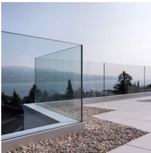
Eksempel på tagterrasseværn udført med indspændt glas.
