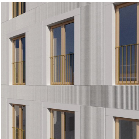
Relief Eksempel på relief facade udført i beton.
