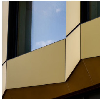
Solcellefacade Monteret med forskellig horisontale og vertikale formater, der vinkler og giver variation til facaden
