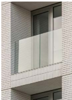
Eksempel på altanværn udført oven på dæk.
