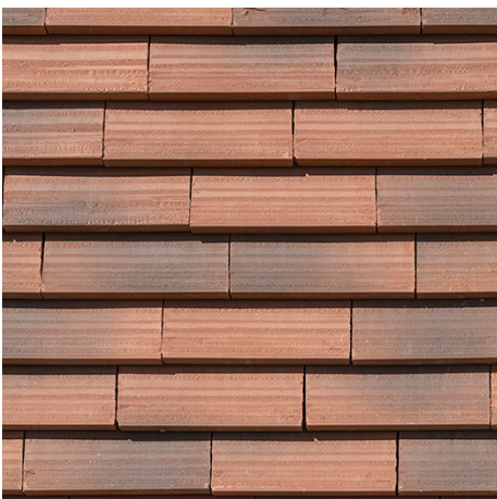
Eksempel på skærmtegl opført med forskudt forbandt.
