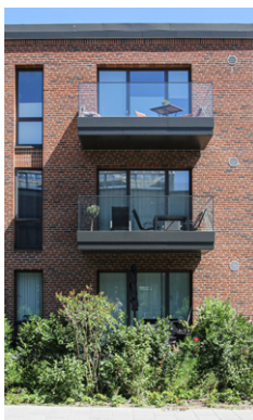
Eksempel på altanværn udført som indspændt glas.
