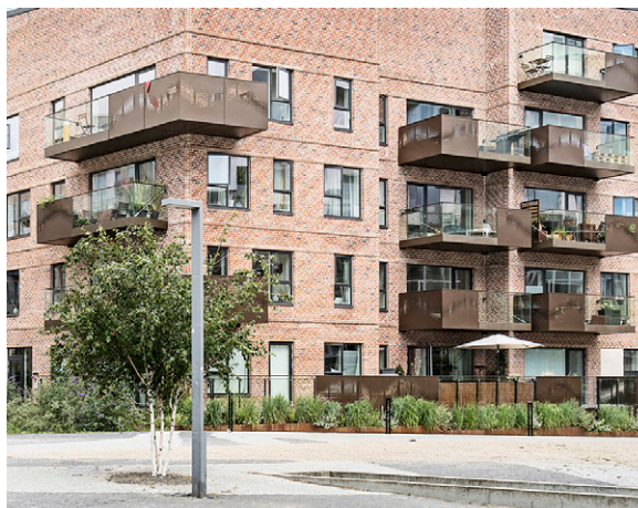
Eksempel på altanværn udført i kombination af glas og lukkede plademateriale. Den lukkede del er her perforeret med hulmønster.
