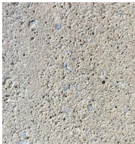
Sandblæst Eksempel på sandblæst beton overflade.
