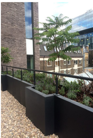
Eksempel på tagterrasse værn udført i kombination med planterbed der giver en begrønning..
