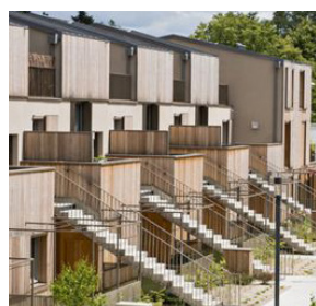
Referencen viser tæt lav bebyggelse med adgang via trapper til den øvre etage.
