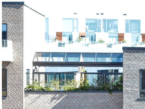
Eksempel på tagterrasse værn udført i kombination med planterbed der giver er begrønnet udtryk..
