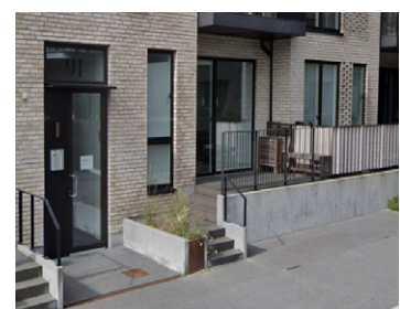
Kantzone med privat trappe fra boligens stueetage til terræn, samt mulighed for privat indretning af kantzone. I kombination med trappen er opsat fast plantekumme.
