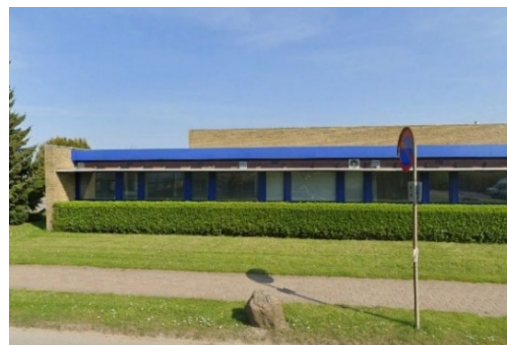
Figur 9: Foto, som viser områdekarakteristisk bebyggelse for Hersted Industripark. Bygningerne er opført i gule mursten med flade tage.
