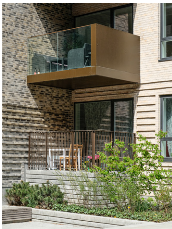
Eksempel på altanværn udført i kombination af glas og lukkede plademateriale. Her lukket på den ene side for at skærme mod nabo.
