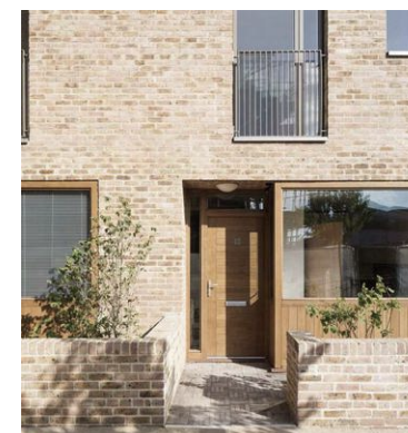
Eksisterende mur i lav version mod parkrum
