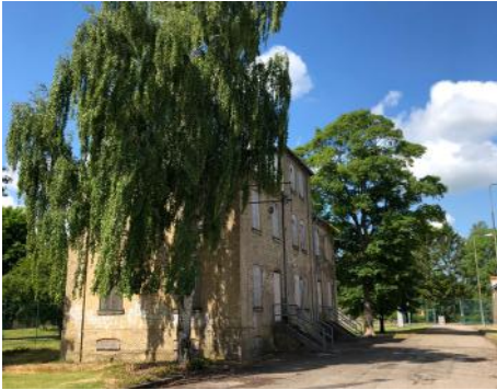
Store løvtræer står flere steder i symbiose med de gamle bygninger
