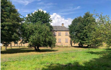
Vridsløselille - Solitære træer på plæne foran de gamle fængselsbygninger
