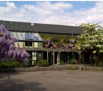
Kvartersplads og fælleshus Reference: Galgebakken
